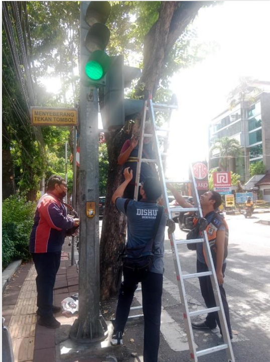
PERBAIKAN RAMBU BERATCS DISHUB KOTA DENPASAR ( PERBAIKAN PENDESTRIAN)
