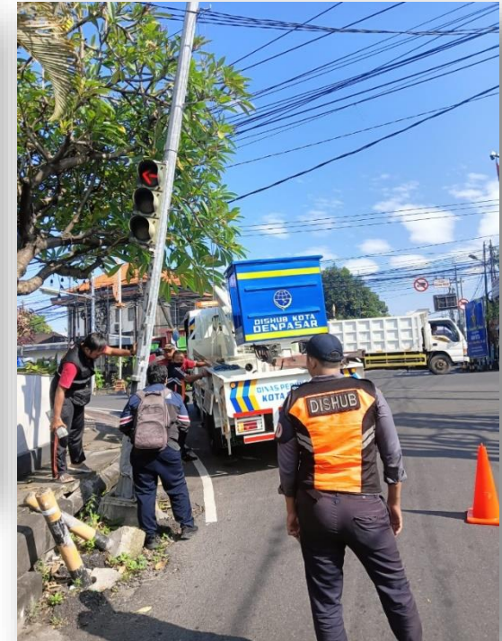
PROSES PELEPASAN TIANG RAMBU TRAFFIC LIGHT ATCS DISHUB KOTA DENPASAR
